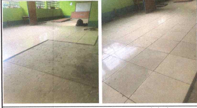
Foto 2: Se observa el remozamiento de piso en áreas priorizadas.
