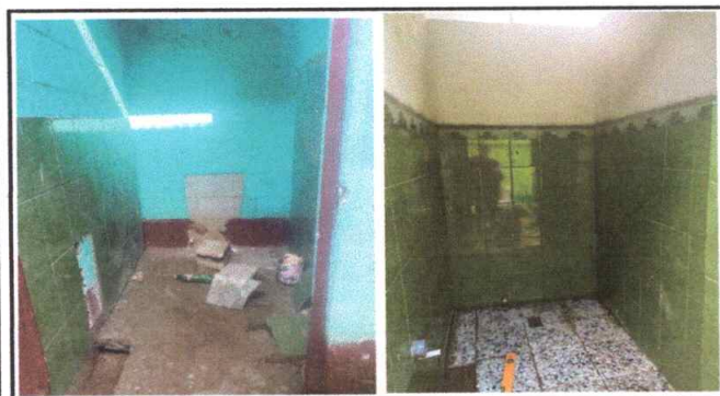
Foto 3: Se observa el remozamiento en el area de baños .
