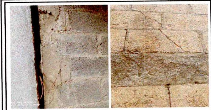
Foto1: se observan paredes en mal estado en el area de cocina.
