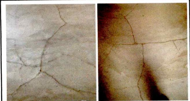
Foto 2: Se observa el piso en mal estado egretado por todas partes.
