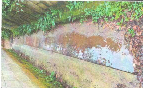
Foto 2: REPARACION DE CERNIDO Y REOELLO EN PAREDES
