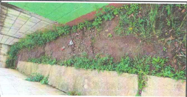
Foto 3: LOSA DE PATIO
