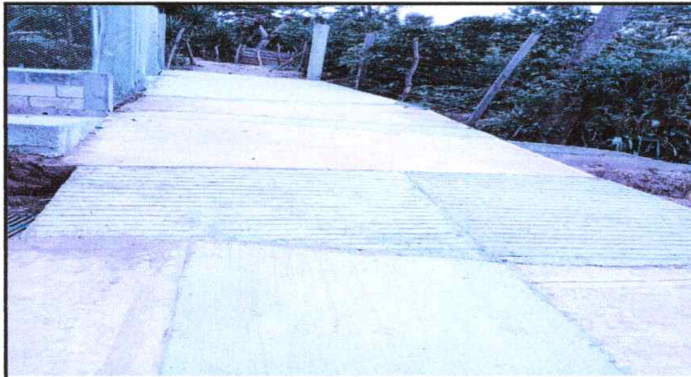
Foto 3: Reparación de losa de patio (sustitución y fundición)
