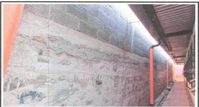
Foto4: Reparacion de Canales y bajadas de agua pluvial
