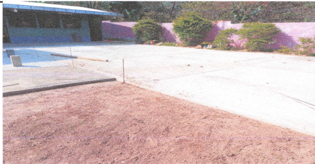
Foto: 5 Reparacion de losa de patio en mal estado
