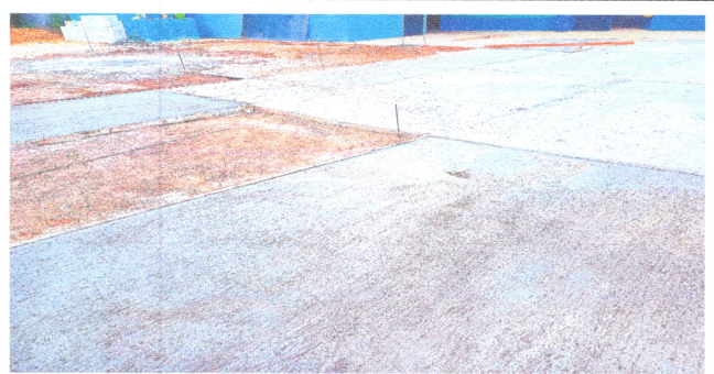
FOTO 2: Reparacion de losa en mal estado
