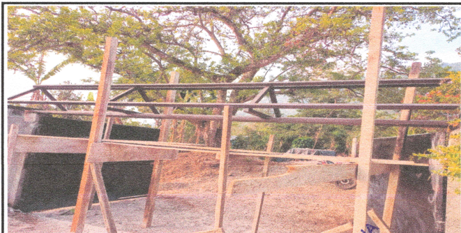
Foto: 6 Reparacion de Canales y bajadas de agua pluvial
