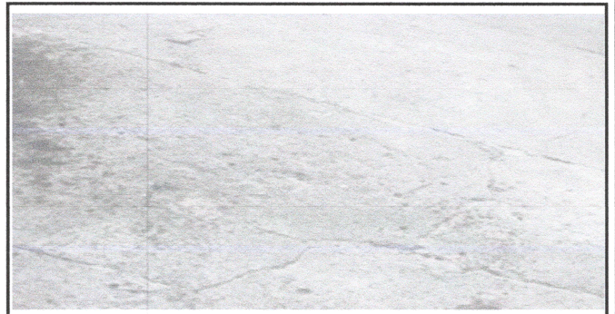
FOTO 2: Reparacion de losa en mal estado
