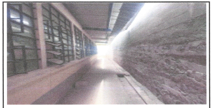
Foto: 6 Reparacion de Canales y bajadas de agua pluvial
