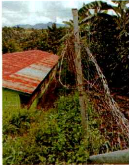
Foto 10: REPOSICION DE CERCO PERIMETRAL
