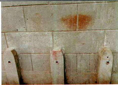
Foto 7: REPARACION DE TUBERIA DE AGUA ENTUBADA PARA MÓDULO DE SANITARIOS Y LAVAMANOS
