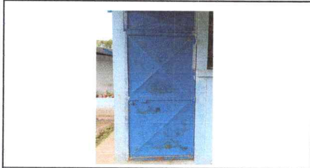
Foto1: Limpieza y pintura de puertas
