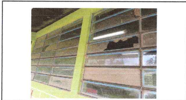
Foto 2: Limpieza general de ventanales
