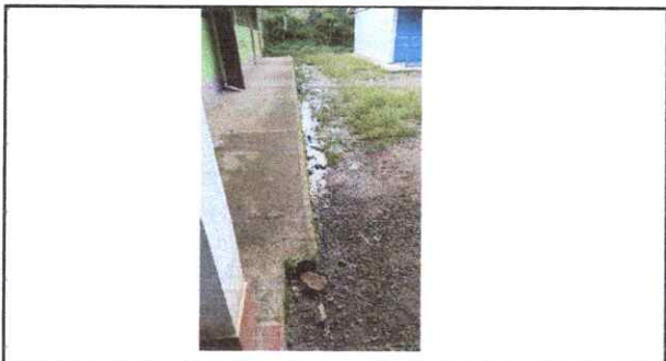
Foto 4: Reparación y reposición de cunetas
