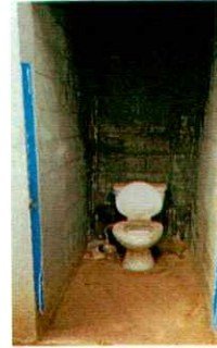
Foto 8: LIMPIEZA Y HABILITACIÓN DE SANITARIOS
