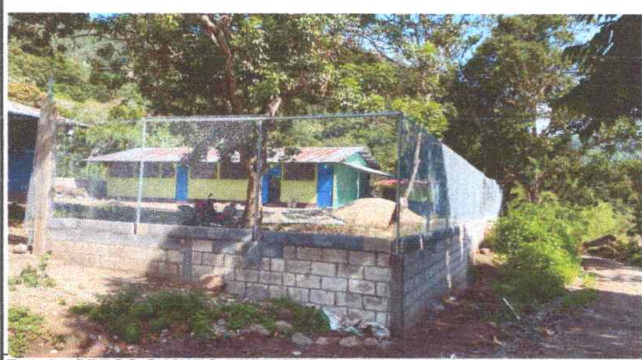
Foto 1: CERCO O MURO PERIMETRAL TERMINADO
