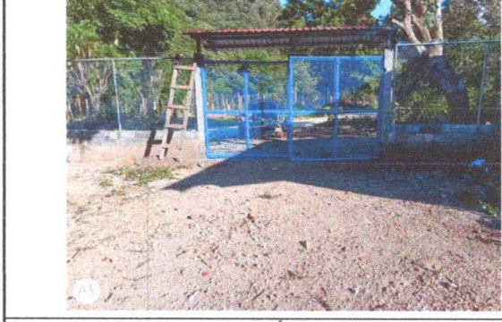
Foto 2: MANTENIMIENTO A PORTÓN EN SU FASE FINAL
