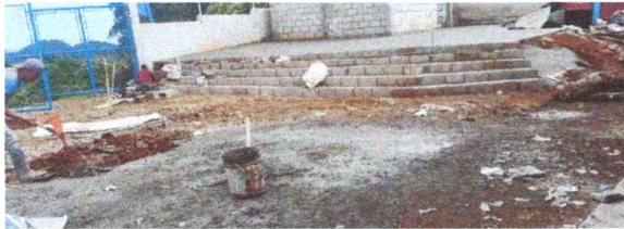
Foto3: RENGLÓN NO. 5 LOSA DE PATIO , SE TIENE ESTRUCTURADO EN UN 60%
