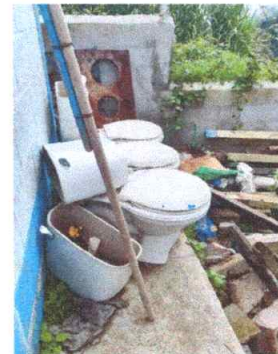
Foto4: RENGLÓN NO. 10 , SERVICIOS SANITARIOS Y SUS ACCESORIOS., SE SUSTITULLERON 3 SANITARIOS EL CUA SE TIENE ESTRUCTURADO EN 50%
