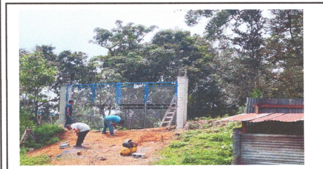
Foto: 5 MANTENIMIENTO A PORTONES
