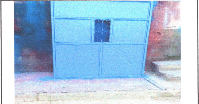
FOTO 2: SUSTITUCION DE PUERTAS
