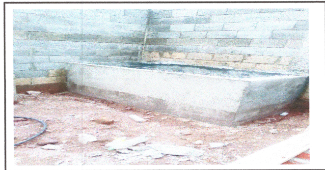
Foto: 6 SUSTITUCIÓN DE TANQUE DE AGUA
