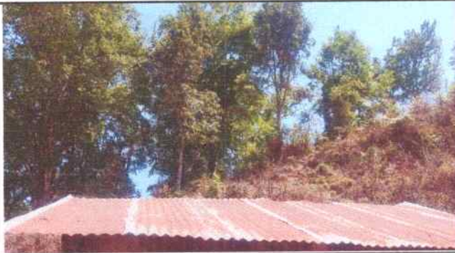
FOTO 1: CUBIERTA DE LAMINA
