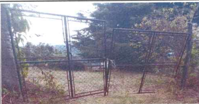
Foto: 5 MANTENIMIENTO DE PORTONES
