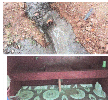
Foto: 6 Reparación de drenajes del área de los sanitarios y la cocina.
