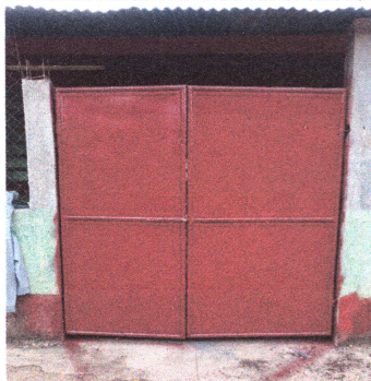
Foto: 5 Reparación y sustitución del portón del ingreso y egreso principal.
