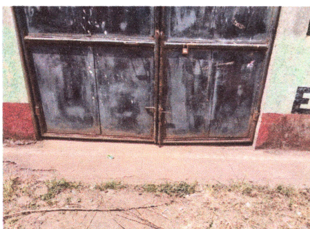
Foto: 5 Reparación y sustitución del portón del ingreso y egreso principal.
