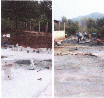
Foto7: Sustitución de terracería por losa de cemento, ya que en el invierno se inunda, se hace lodo y no seca en mucho tiempo, provocando demasiada humedad.
