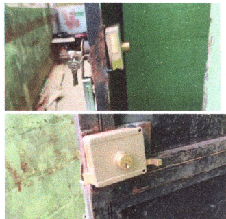
Foto1: Sustitución de chapas y pintura de 6 puertas, incluyendo aulas, sanitarios y cocina.
