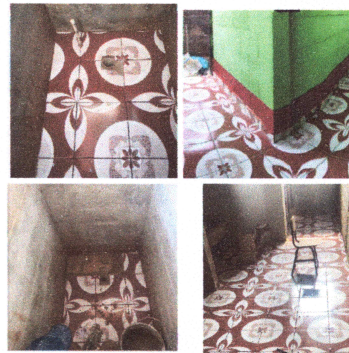
FOTO 2: Sustitución de la torta de cemento por piso, en la cocina, sanitarios y pasillos.
