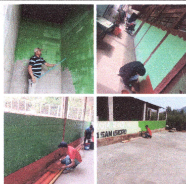
Foto3: Sustitución de pintura en muros interiores y exteriores.
