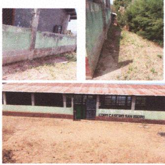
**Foto7:** Sustrucción de terracería por losa de cemento, ya que en el invierno se inunda, se hace lodo y no seca en mucho tiempo, provocando demasiada humedad.
