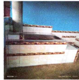
Foto 4: REPARACION DE AZULEJO
