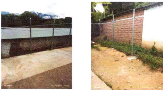
Foto 5: REPARACION DE CERCA PERIMETRAL
