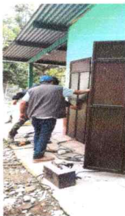
Foto 1: REPARACION DE PUERTA DE SANITARIO EN 50%
