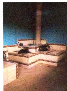
Foto 4: REPARACION DE AZULEJO EN UN 60%
