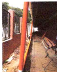
Foto 2: REPARACION DE CANALES Y CAÍDA DE AGUA PLUVIAL
