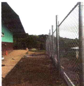
Foto 5: REPARACION DE CERCA PERIMETRAL EN UN 60%
