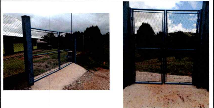
Foto 6: Mantenimiento a portones finalizado
