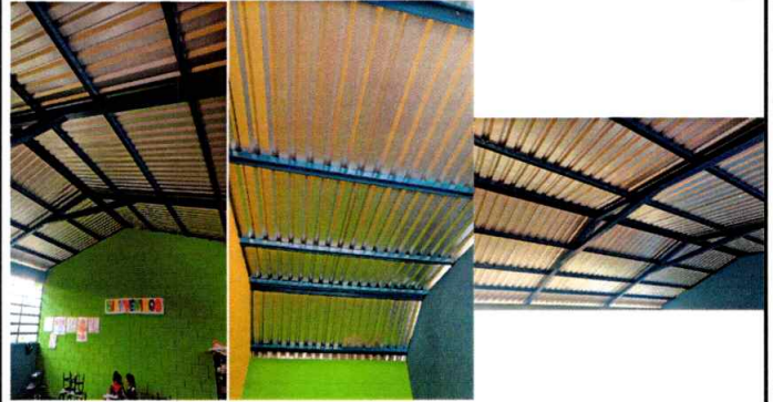
Foto 2: Estructura de techo finalizado
