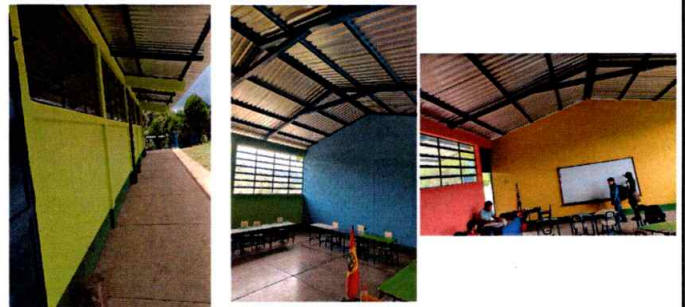
Foto 4: pintura en muros interior y exterior finalizado
