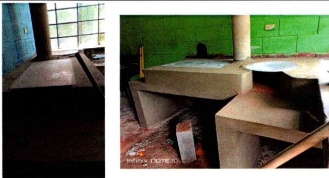
Foto 5: Reparacion de area de cocina finalizado
