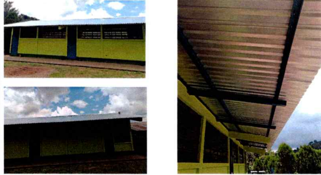
Foto1: Cubierta de lamina finalizado
