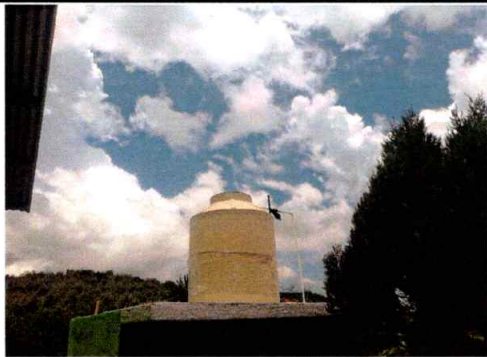
Foto 3: Reparacion y mantenimiento de deposito de agua finalizado.
