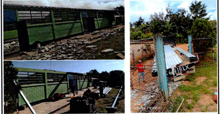
Foto 2: Estructura de techo en proceso
