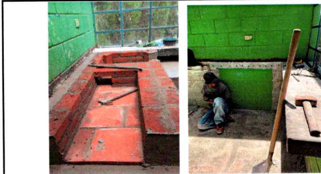
Foto 5: Reparacion de area de cocina en proceso
