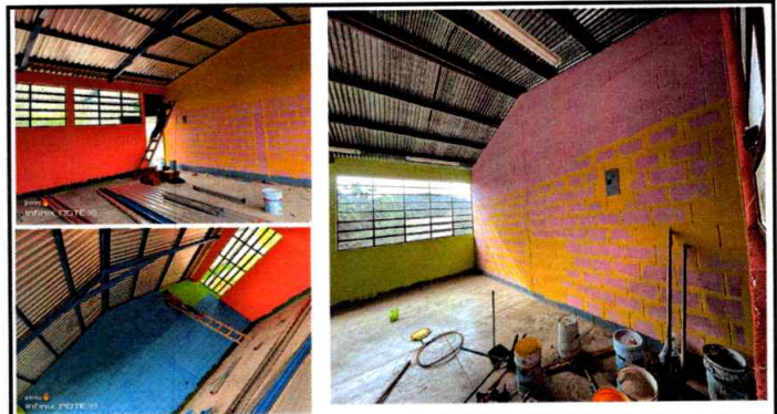
Foto 4: pintura en muros interior y exterior en proceso
