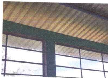
Foto 4: SUSTITUCIÓN, Y REPARACIÓN DE VENTANAS
