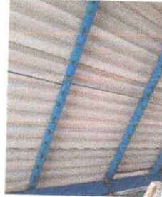
Foto 2: SUSTITUCIÓN DE LA ESTRUCTURA DEL TECHO
