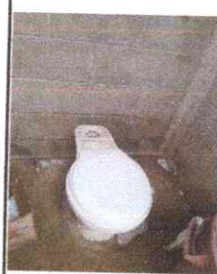
Foto 6: SUSTITUCIÓN COMPLETA DE SANITARIOS
