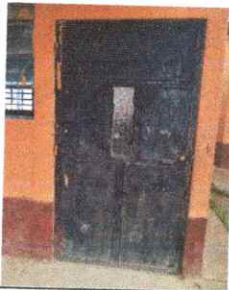
Foto 3: SUSTITUCIÓN DE PUERTA
