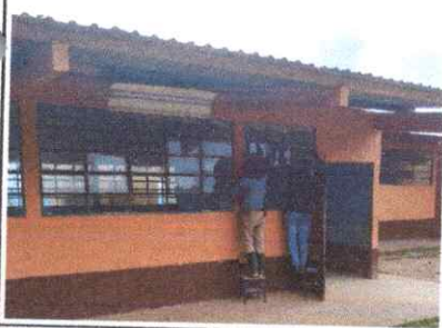
Foto 5: SUSTITUCIÓN DE PINTURA AGUA Y ACEITE
