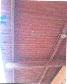
Foto 1: SUSTITUCIÓN DE TECHO
