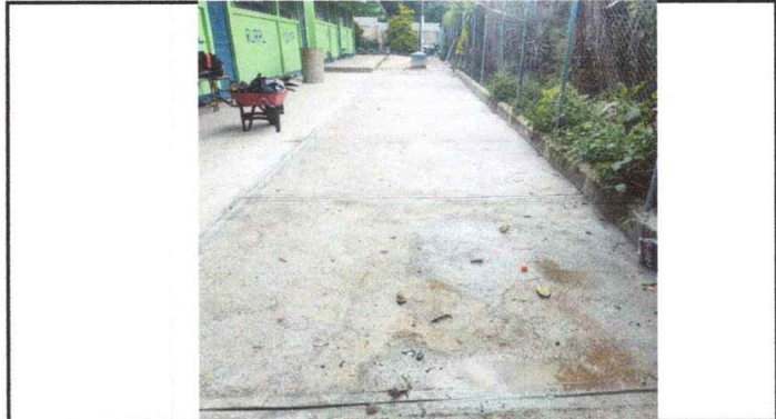
Foto 4: losa de patio
