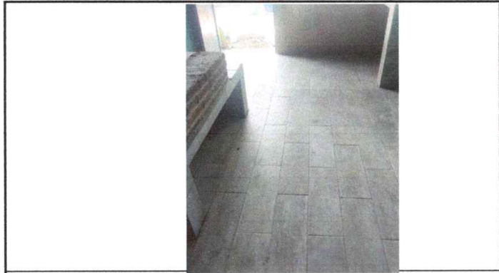
Foto1: Instalación de Piso
