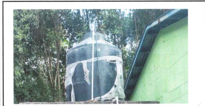
Foto 5: Deposito de Agua
