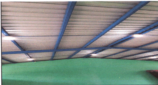
Foto: 5 REPARACION DE SISTEMA ELECTRICO.
