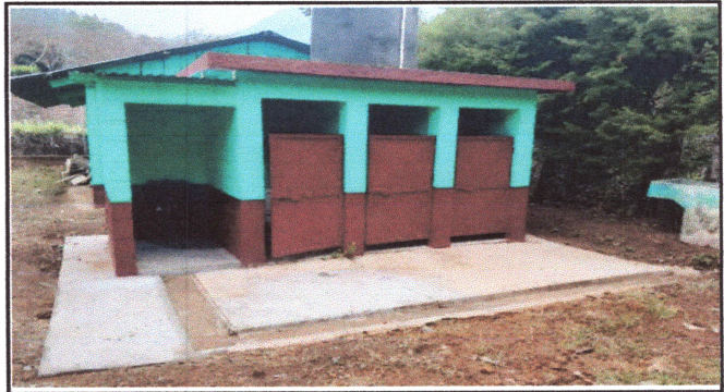
FOTO 2: REPARACION DE RED DE DRENAJE Y AGUA POTABLE
