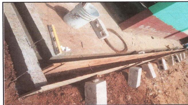
Foto4: REPARACION DE CUNETETA DE CONCRETO
