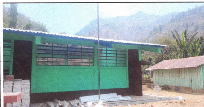
Foto: 5 PINTURA DE MUROS EN EXTERIOR
