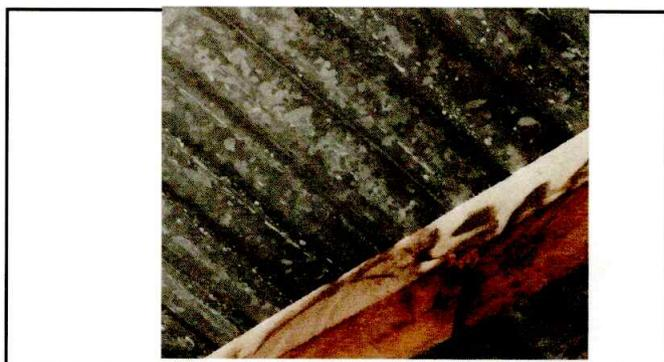
Foto 4: Mal estado de vigas de techo
