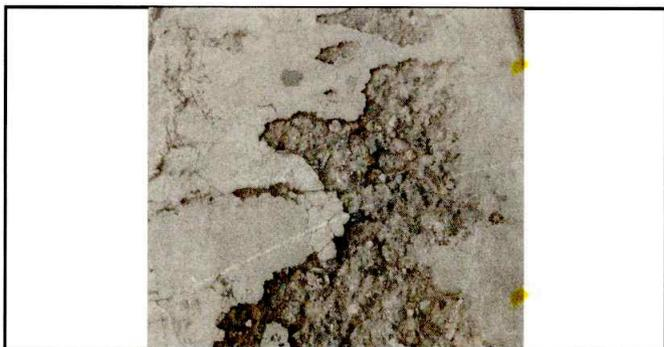
Foto 6: Se evidencia losa de patio en mal estado
