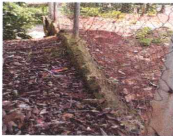
Foto 5: cerco o muro perimetral (sustitución de malla, blocks quebrados y tubos galvanizados)
