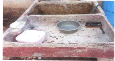
Foto 8: Reparación o sustitución de área de cocina (estufa rurales, pilas, ventanas, puertas, chimeneas, etc)
