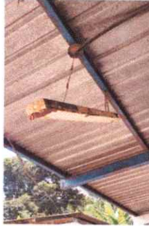
Foto 7: Reparación de sistema eléctrico
