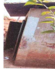
Foto 2: Puertas (sustitución de puertas)
