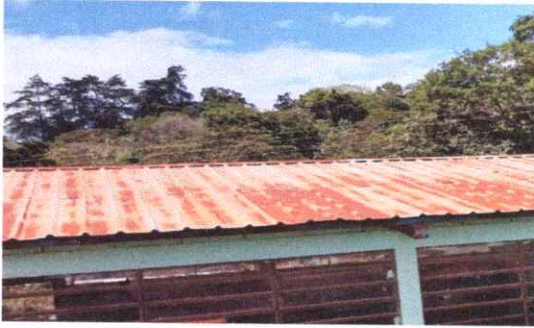
Foto 1: Cubierta de lámina (sustitución de lamina troquelada por mal estado)
