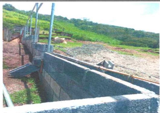
Foto 4: Se evidencia el trabajo de sustitución de cerco o muro perimetral con block y tubo en 50% de trabajo.
