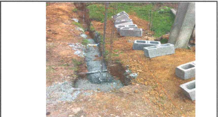
Foto 4: Cerco o Muro Perimetral se inicia el trabajo en un 10%
