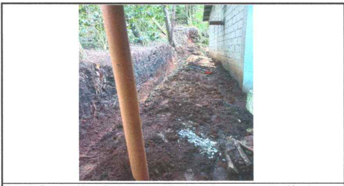
Foto 5: Cerco o Muro Perimetral: inicio de sanjeo para sustitución de cerco o muro
