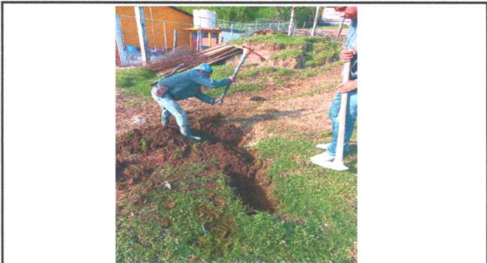
Foto 3: Reparación de drenajes: Inicio de de reparación de drenajes
