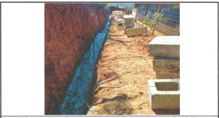
Foto 6: Cerco o Muro Perimetral: Se evidencia el trabajo de fundición para cerco muro perimetral
