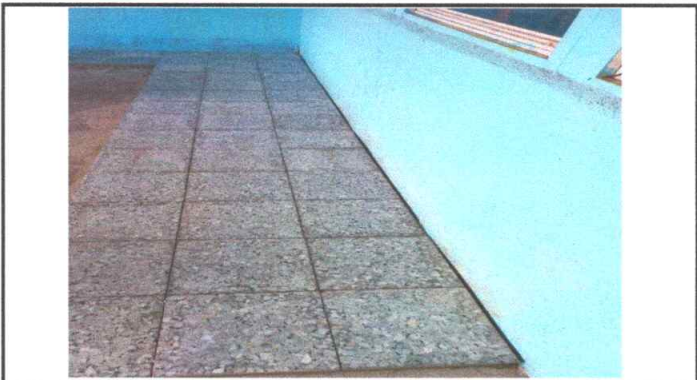
Foto1: Piso: Inicio de colocación de piso
