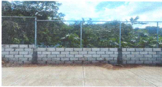
Foto 1: cerco o muro perimetral (sustitución por mal estado de la malla y block quebrados)
