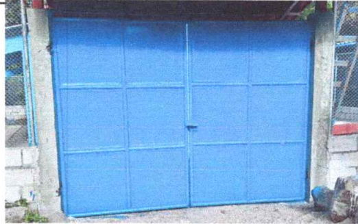
Foto 2: mantenimiento a portón (sustitución por daños y oxido)
