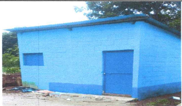
Foto 4: Pintura en muros interior exterior
