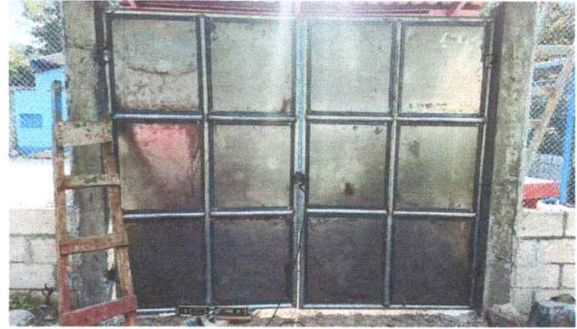
Foto 2: mantenimiento a portón (sustitución por daños y oxido)
