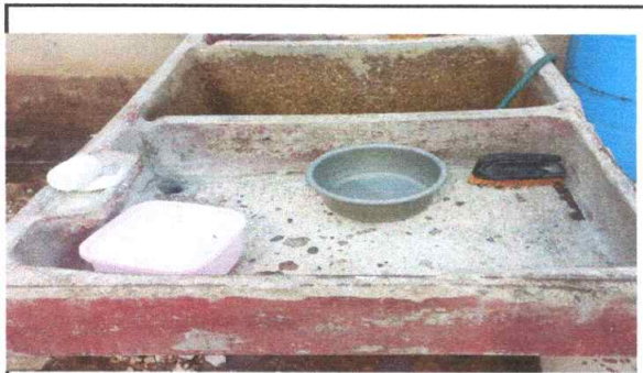
Foto 3: Reparación de area de cocina (sustitucion de pila quebrada)
