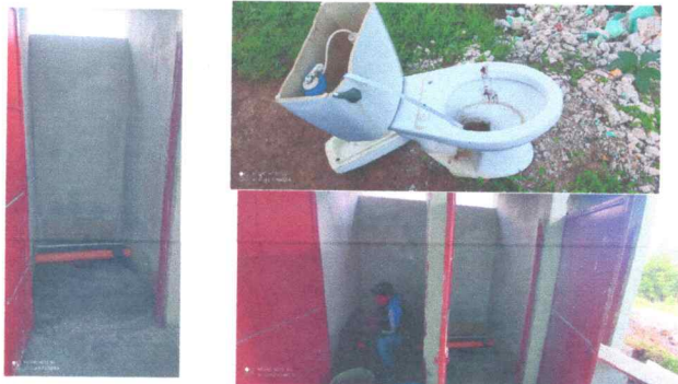
Foto3: Reparacion y sustitucion de servicios sanitarios
