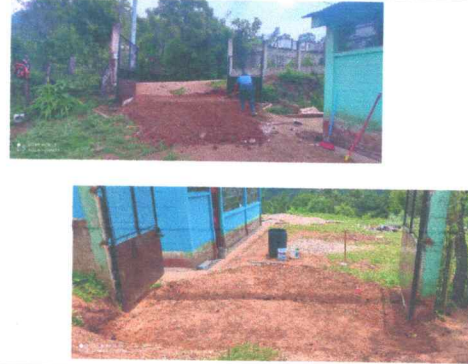
Foto4: Reparacion y mantenimiento de porton
