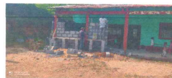
Foto4: Susitucion de pared
