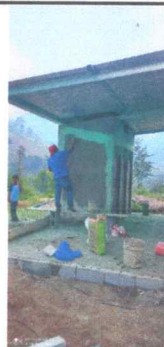
FOTO 2: Reparación y ampliación del repello y cernido de área de baños
