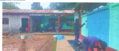
Foto1: Pinturas en muros exteriores e interiores
