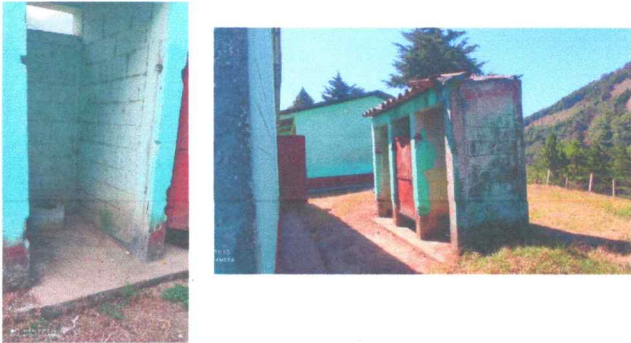
Foto1: Sustitucion y reparacion de servicios sanitarios
