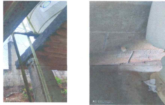
Foto4: Reposicion de red de agua potable y drenajes
