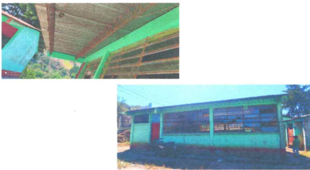
Foto: 5 Sustitucion de tendido electrico, ventas y pintura
