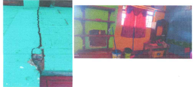
FOTO 2: Reposicion de paredes
