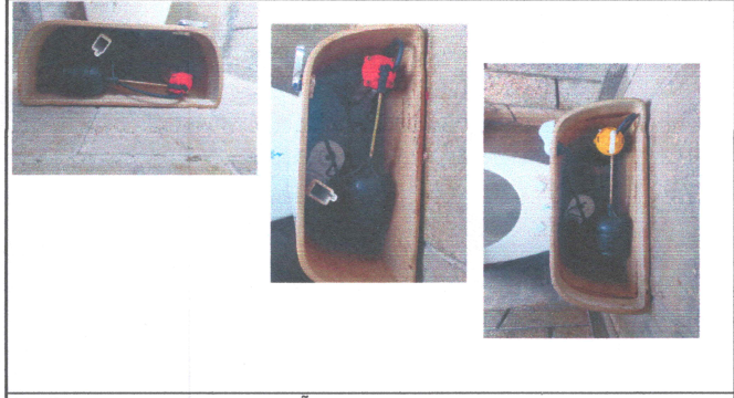
FOTO 2: REPARACION DE BAÑOS
