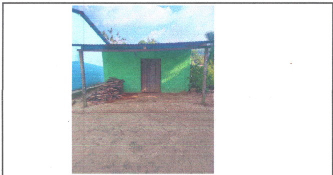
FOTO 4: SUSTITUCION DE TECHO
