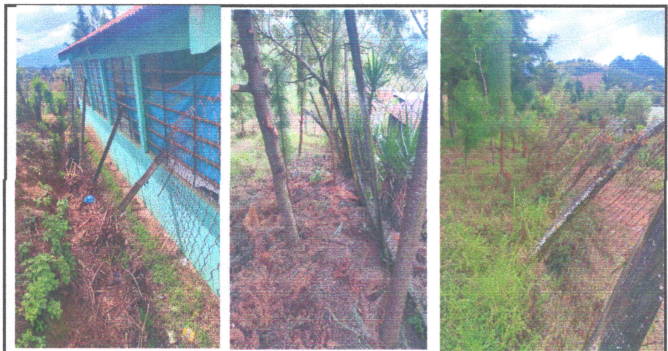
Foto3: SUSTITUCION DE CERCO PERIMETRAL
