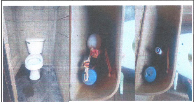
FOTO 2: REPARACION DE BAÑOS
