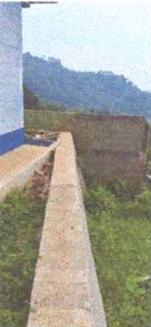
FOTO 8: PARTE DE MURO QUE SE NECESITA MAYA
