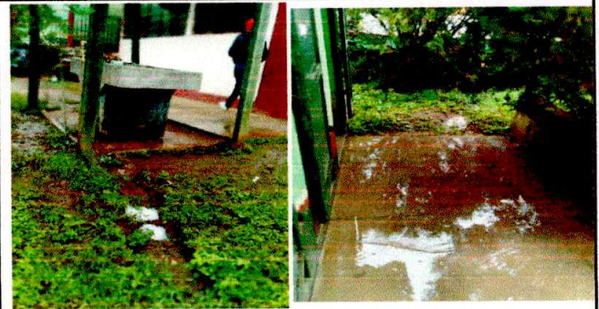
FOTO 2: REPARACIÓN DE DRENAJE
