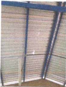
Foto 1: SUSTITUCIÓN DE TECHO
