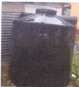
Foto 5: SUSTITUCIÓN DE DEPOSITO DE AGUA(TIPO ROTOPLAS)
