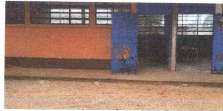
Foto 2: PINTURA INTERIORES Y EXTERIORES
