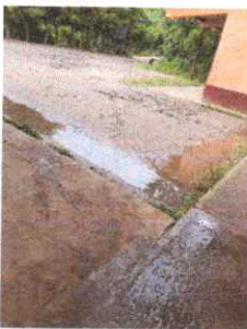
Foto 3: LOSA DE PATIO
