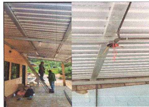
Foto: 6 REPARACION DE SISTEMA ELECTRICO: Reparacion del sistema electrico en general aula y cocina (renglon 6)
