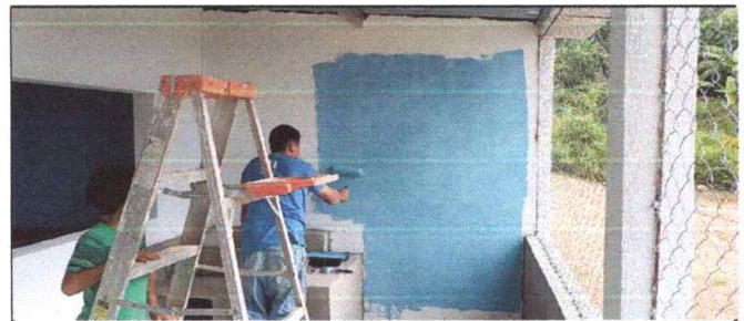
Foto4: PINTURA EN MUROS INTERIOR Y EXTERIOR: Aplicación de pintura en paredes del aula y de la cocina interna y externa. (renglon 4)
