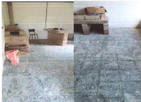
Foto3: PISO: Instalacion de piso en area de cocina ( renglon 3)
