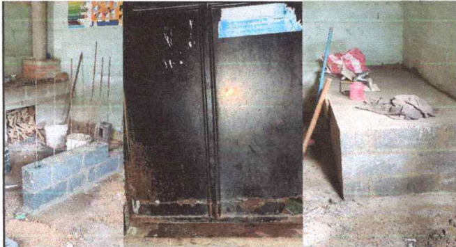
Foto7: REPARACION O SUSTITUCION DE AREA DE COCINA (ESTUFAS RURALES, PILAS, VENTANAS, PUERTAS, CHIMENEAS, ETC.) Instalacion de estufa, de ventana, puerta y ampliacion de pared en area de cocina.
