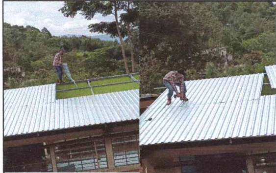
Foto1: SUSTITUCION DE CUBIERTA DE LÁMINA: Sustitucion en aula (renglón 1)
