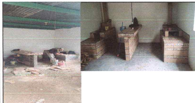
Foto: 5 Sustitucion de azulejo en area de cocina (renglon 5)
