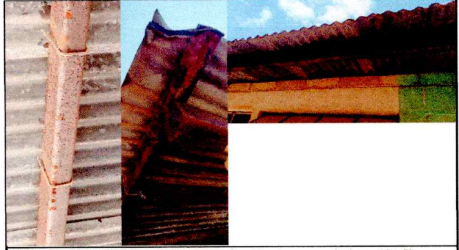
FOTO 2: ESTRUCTURA DE TECHO: Sustitucion en aula (renglón 2)
