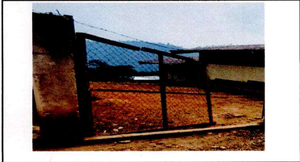
Foto 1: Reparación del portón principal
