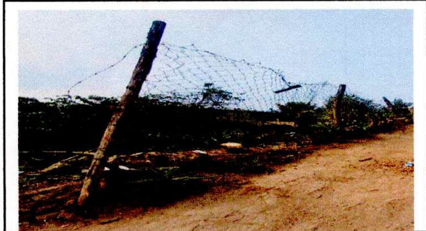
Foto 3: Reparación del muro
