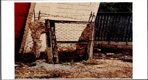
Foto 2: Reparación de puerta del costado
