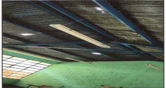
Foto 2: LAMINA DE AULAS DE PÁRVULOS
