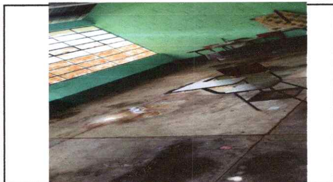
Foto 3: PISO DE AULAS DE PÁRVULOS
