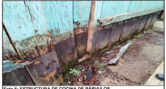
Foto 6: ESTRUCTURA DE COCINA DE PÁRVULOS
