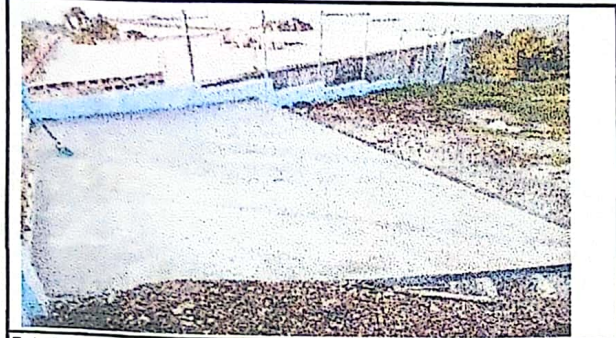
Foto1: FUNDICION DE LOSA DE PATIO
