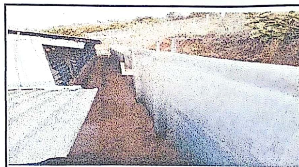
Foto4: MURO DE CONTENICION FINALIZADO VISTA LATERAL ALTA
