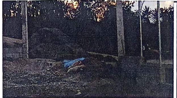
FOTO 2: PREPARACION Y NIVELADO DE SUELO
