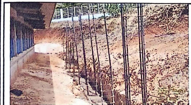
Foto: 5 FUNDICION DE ZAPATA Y COLUMNAS
