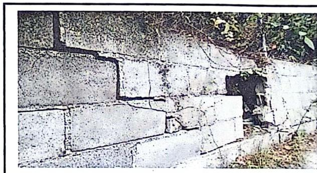
Foto4: CUANDO SE DERRUMBO EL MURO DE CONTENCIÓN
