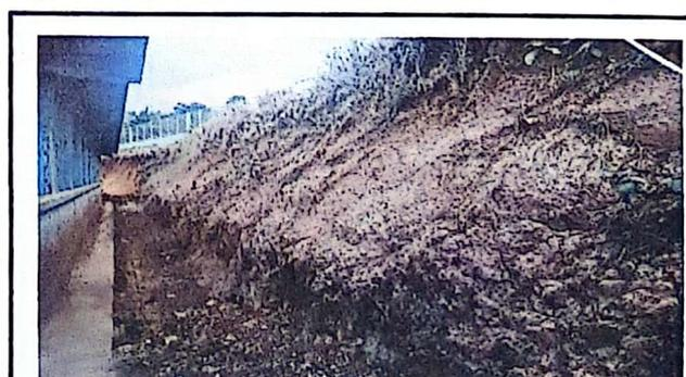
Foto: 6 IMAGEN DE COMO QUEDO DESPUES DE LA CAIDA DEL MURO DE CONTENCIÓN POR DESLAVE
