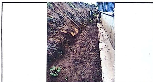
Foto: 5 LIMPIANDO ESCOMBROS DE CAIDA DE MURO DE CONTENCIÓN
