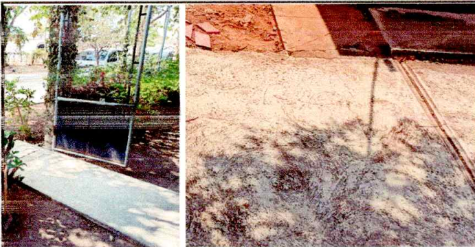
Foto: 5 LOSA DE PATIO
