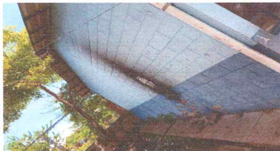
Foto 5: SUSTITUCION DE PINTURA BASE AGUA
