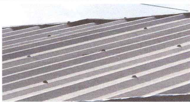
Foto1: SUSTITUCIÓN LAMINA TROQUELADA CALIBRE 26
