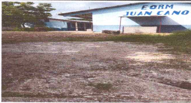
Foto 7: SUSTITUCIÓN LOSA DE PATIO INCLUYE BASE, FUNDICION Y ACABADO
