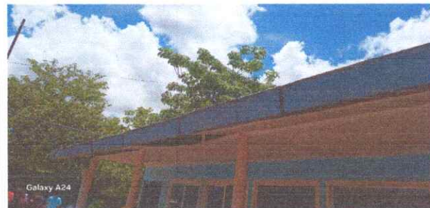
Foto 4: REPARACION Y MANTENIMIENTO DE CANALES Y BAJADAS 4"
