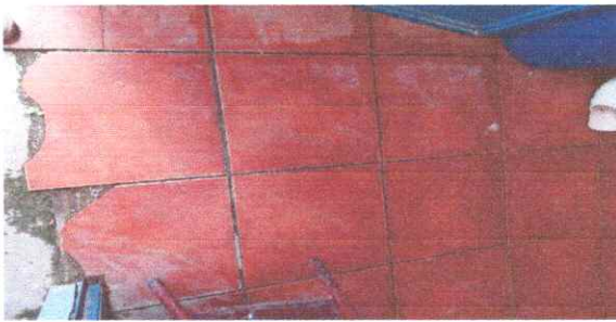
Foto 3: SUSTITUCIÓN PISO CERÁMICO (INCLUYE BASE DE CONCRETO)
