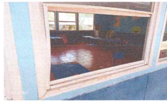
Foto 2: REPARACIÓN Y MANTENIMIENTO DE VENTANAS, PINTURA, SILICON, LIMPIEZA DE VIDRIOS
