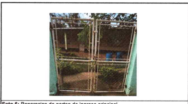
Foto 6: Reparacion de porton de ingreso principal
