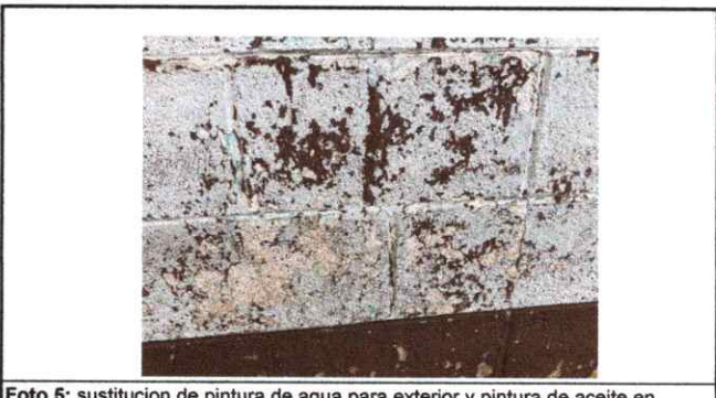
Foto 5: sustitucion de pintura de agua para exterior y pintura de aceite en zocalo
