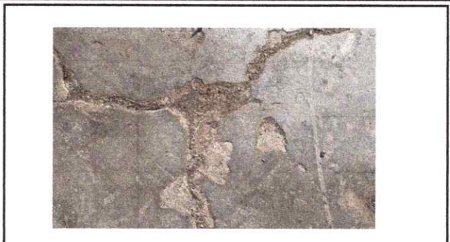
Foto 8: Sustitucion de losa de patio
