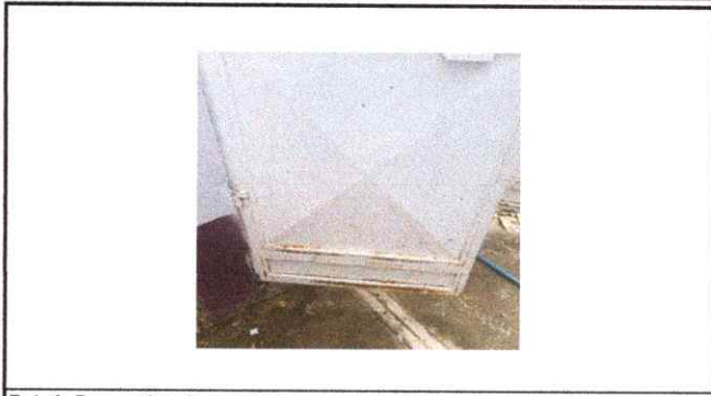
Foto 1: Reparacion de puertas en area de baños
