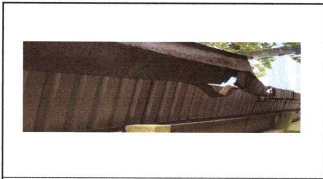
Foto 4: Sustitucion de canales pluviales
