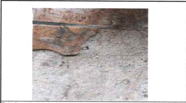
Foto 3: sustitucion de piso ceramico
