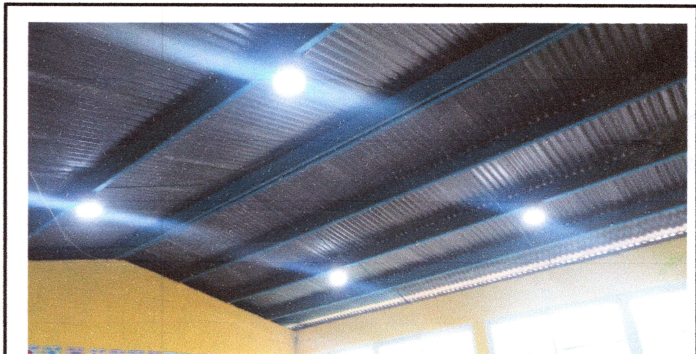
Foto: 6 TERMINADO EL TRABAJO DE REPARACIÓN DEL SISTEMA ELÉCTRICO
