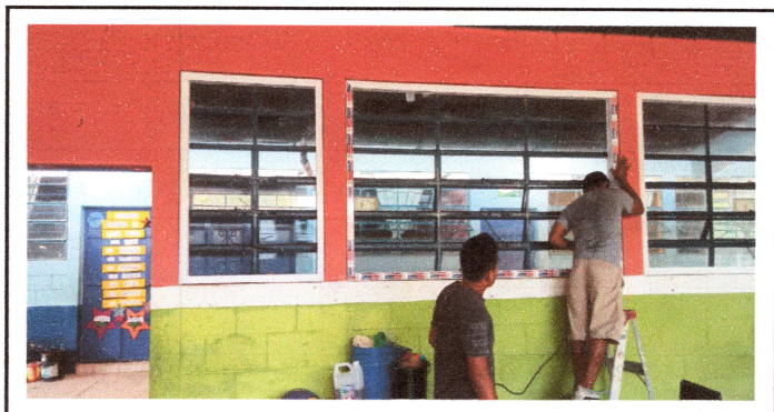
Foto4: CAMBIO DE VENTANAS TERMINADO
