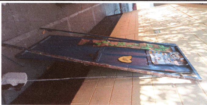
Foto: 5 REALIZANDO TRABAJO DE CAMBIO DE PUERTA
