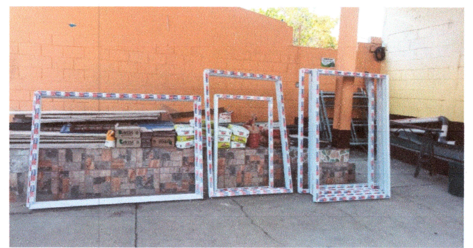
Foto4: TRABAJANDO CAMBIO DE VENTANERIA
