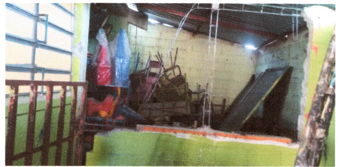
FOTO 2: TRABAJANDO REPARACIÓN DE PARED PARA CORREGIR GRIETAS
