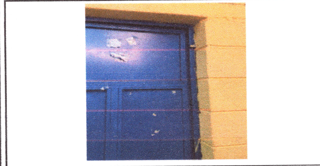
Foto: 5 SE REALIZARA EL CAMBIO DE PUERTA PARA QUE PUEZA EXISTIR MAS ILUMINACION Y VENTILACION
