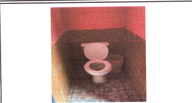
Foto1: SE REALIZARA EL CAMBIO DE SANITARIOS
