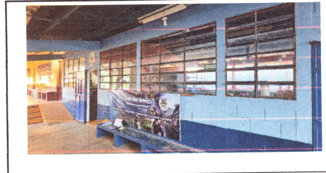
Foto4: SE REALIZARA LA APLICACION DE PINTURA MAS EL CAMBIO DE VENTANERIA
